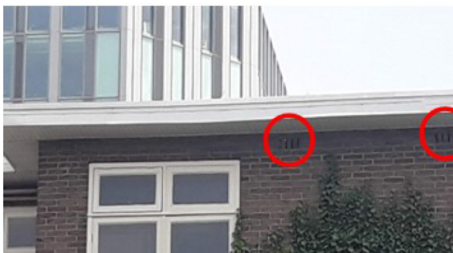
Figuur 7: Een voorbeeld van open stootvoegen in een rijtjeswoning aan de Croeselaan dat toegang verschaft tot de spouw waar zich mogelijk vleermuisverblijfplaatsen bevinden.
