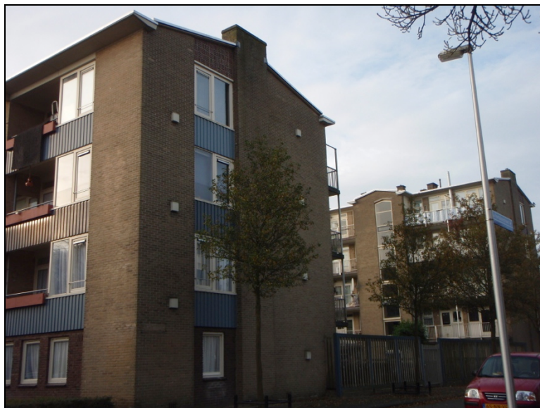
Foto 3.1.6 Woonflats aan de Dickenslaan
